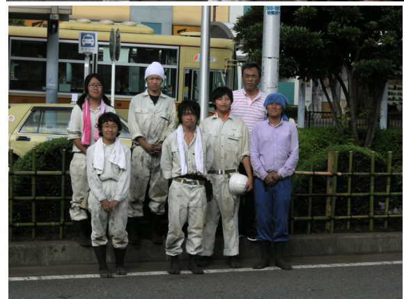
生徒達による竹垣設置工事
