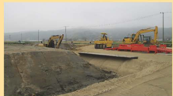
新渡波地区土地区画整理事業(約18ha、計画人口960人)は平成24年12月に認可になり工事が進んでいます。写真は盛土工事の様子(平成25年7月頃)。
