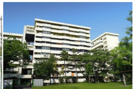
18 年に一度の外壁修繕が終わった住棟。これから中央地区ではじまる。
