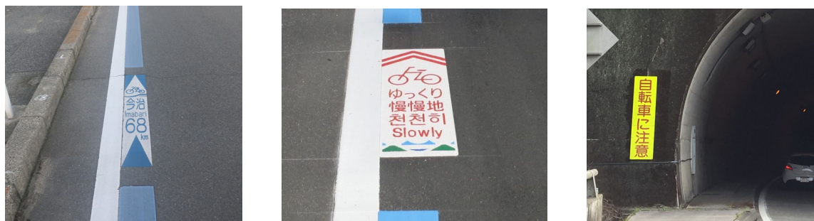
図2 ブルーライン・距離標示（方向標示）やトンネル出入口への注意喚起看板の様子
