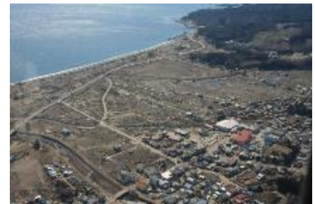
▲城内地区（中心部）の被災状況
