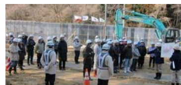
▲協議会による造成工事の視察 ※3-3
