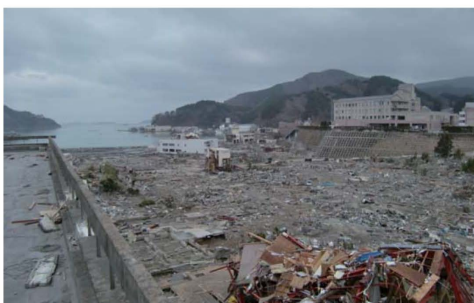
被災直後の状況
